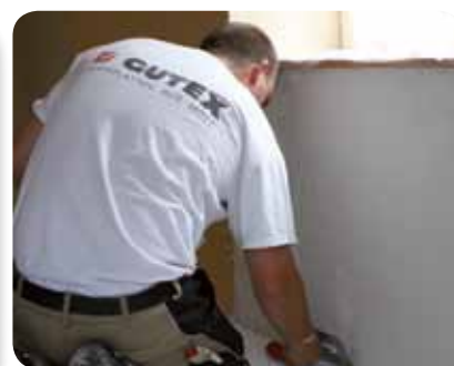
GUTEX dunpleister aanbrengen om achteraf te kunnen behangen
