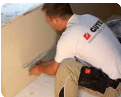
Met GUTEX kleef- en spatelpleister wordt de grondlaag geplaatst.
