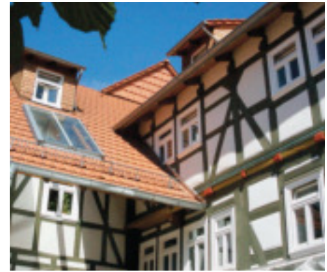
Vakwerkhuzen en eengezinswoningen: eenvoudig naderhand isoleren van plafonds en muren
