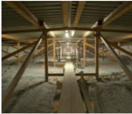
Beste verhouding prijs/prestatie: open opblazen op het plafond van de bovenste verdieping
